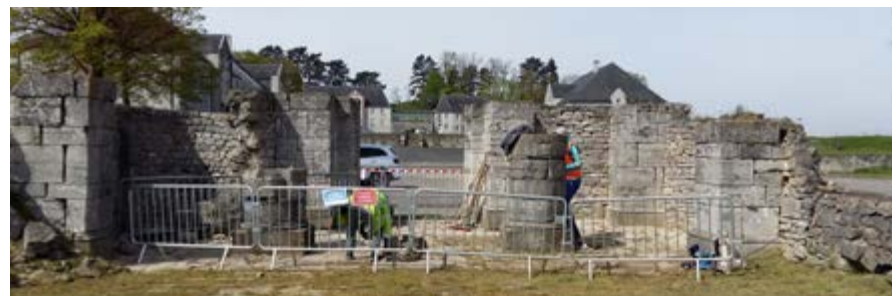
Les travaux de sauvegarde de l'Église à Charlemont
