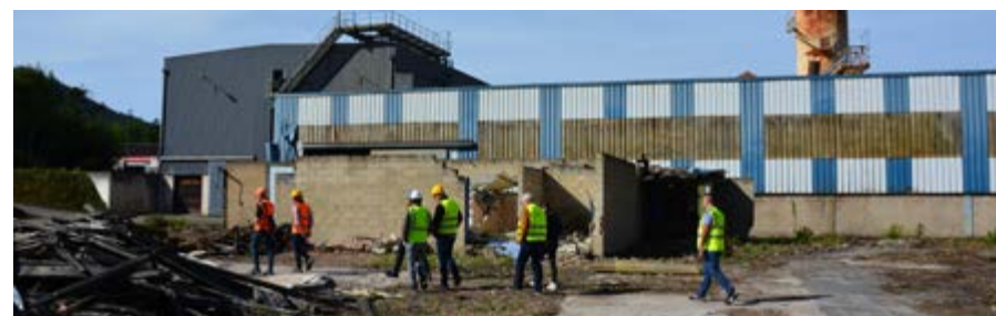
L'avancée des travaux du site Oxame
