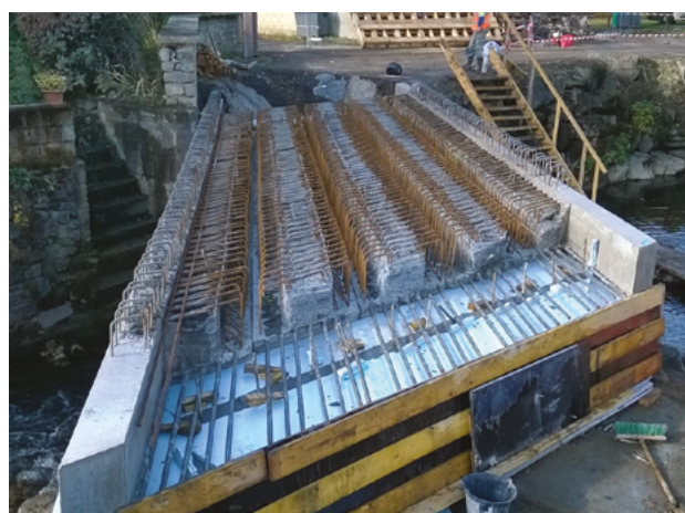
Reconstruction du Mur de berge en amont de la passerelle Mise en place du nouveau tablier de la passerelle
