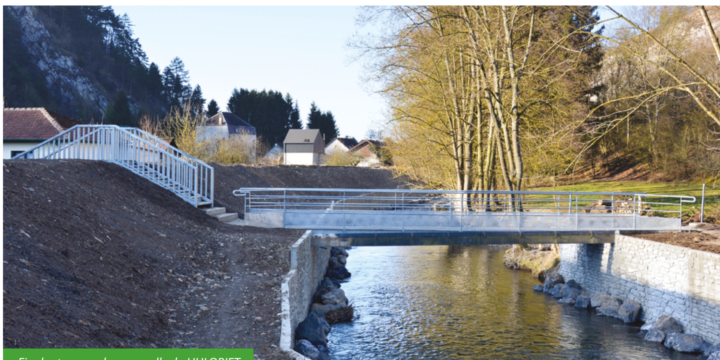
Fin des travaux, la passerelle du HULOBIET
